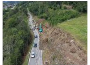
Die Arbeiten an der B 97 gestalten sich überaus herausfordernd. © Granit
