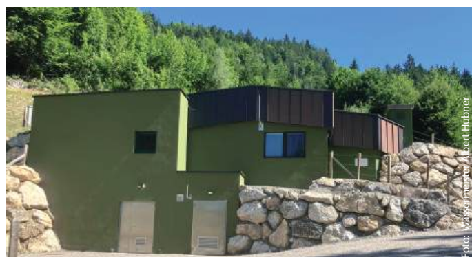
Der neue Hochbehälter am Dreispitz
