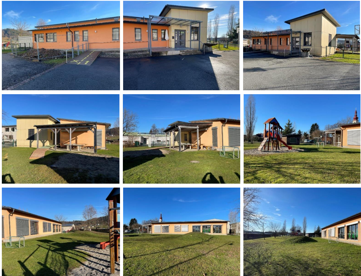
FOTODOKUMENTATION GTS FERNITZ AUSSENBEREICH
