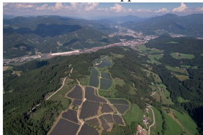
alle Fotos: ©Armin Russold Fotos Die Agri-PV-Anlage von oben. Etwa 32 Gigawattstunden Strom werden mit dieser Anlage pro Jahr
