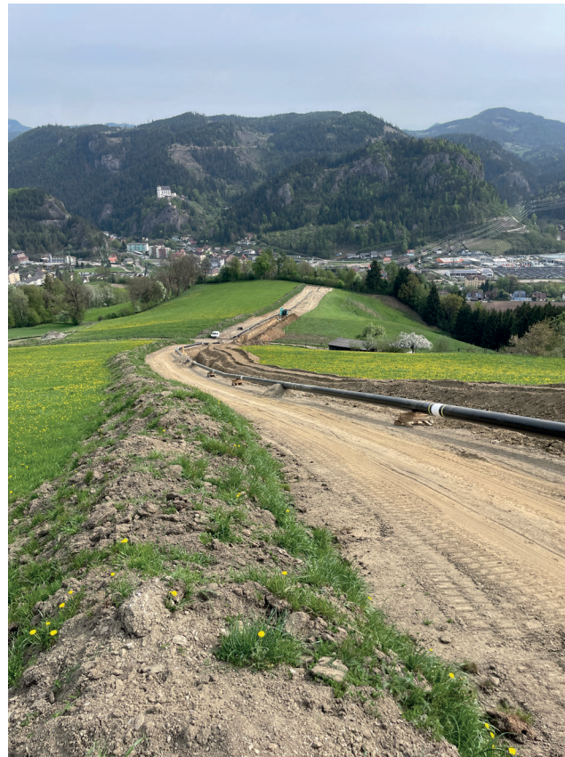
©Energie Steiermark (Text & Foto). Das Foto zeigt die Baustelle im Gemeindegebiet St. Peter-Freienstein, im Bereich Traidersberg.
