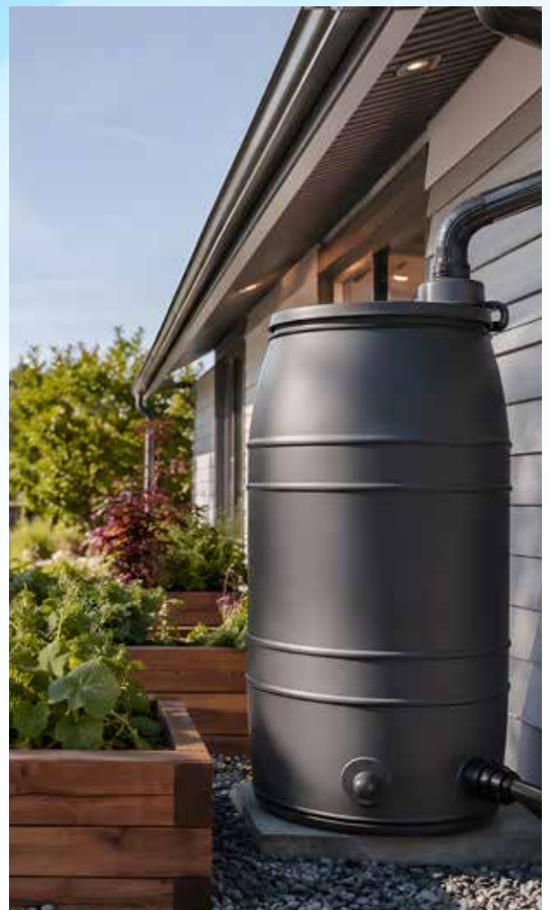
Abb. 4: Das Regenwasser wird direkt aus dem Fallrohr in die Regentonne geleitet. © Adobe.Stock.com
