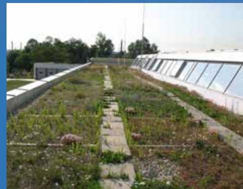
Abb. 11: Extensive Dachbegrünung © DI Karl Grimm
