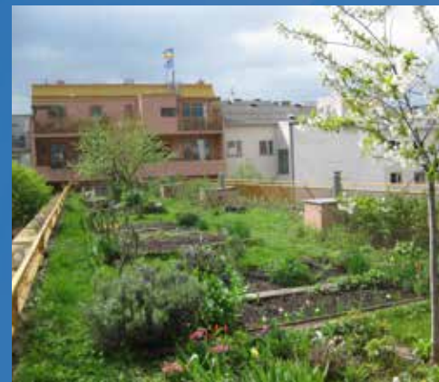
Abb. 12: Intensiv begrünte Dachfläche mit Nutzbeeten © DI Karl Grimm
