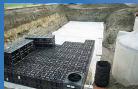
Abb. 27-29: Kunststoffelemente werden eingesetzt. Alternativ kann die Rigol-Anlage auch mit Kies bzw. Schotter ausgeführt werden. © SCHÜTTER Behältercenter
