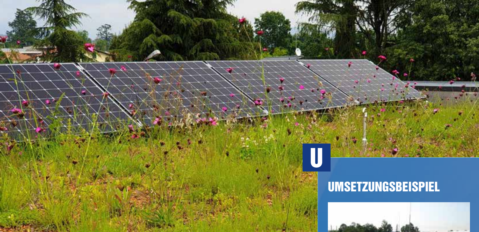
Abb. 9: Dachbegrünungen können problemlos mit Photovoltaik-Anlagen kombiniert werden. Die Begrünung wirkt kühlend und kann im Sommer sogar die Effizienz der Photovoltaik-Anlage steigern. © Adobe.Stock.com
