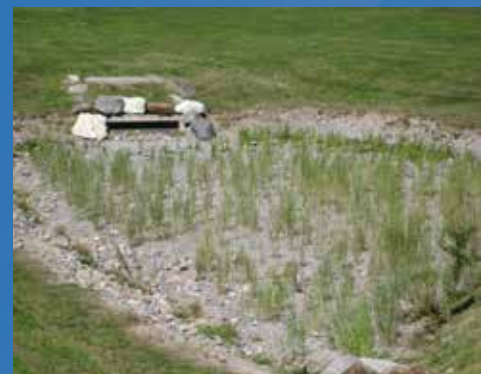
Abb. 40-41: Teichanlage mit Versickerungsmulde © Landesagentur für Umwelt, Amt für Gewässerschutz, Bozen
