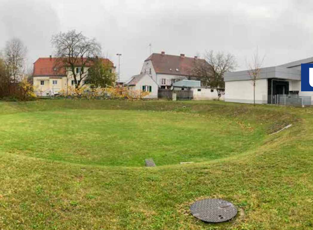
Abb. 20: Versickerungs- und Retentionsbecken der Lidl Österreich GmbH am Standort Feldbach © Stadtgemeinde Feldbach
