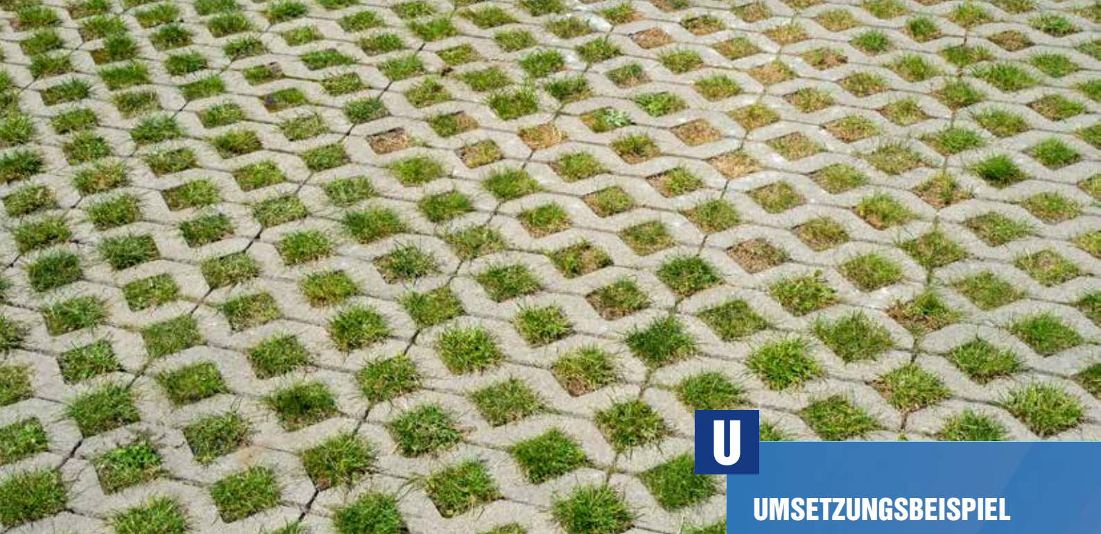
Abb. 14: Rasengittersteine sind eine Möglichkeit, die Oberfläche befahrbar zu machen und gleichzeitig Sickerfähigkeit zu erhalten. © Adobe.Stock.com
